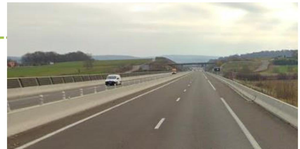
EXEMPLE DE SECTION À 2 x 2 VOIES : LA RN19 À L'EST DU PROJET, À LA HAUTEUR DE BOTANS (source : googlemap)
